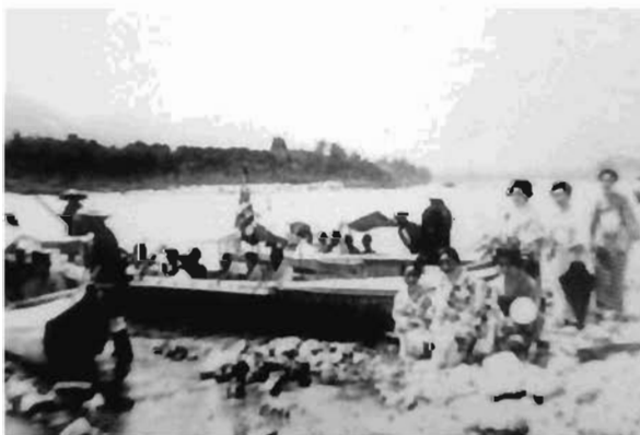
8 太田からのライン下り（時期不詳・太田菰川運の見送り）※
