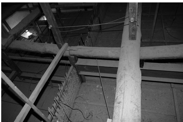
写真⑩ 小屋組 大梁下に鉄骨補強
