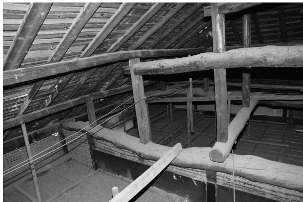
写真⑨ 小屋組 軒を見る
