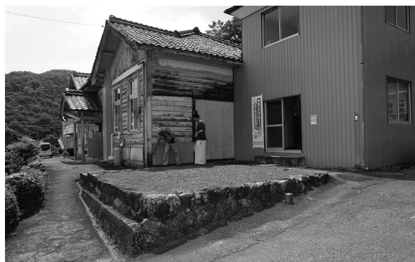
写真② 土蔵跡基礎石垣
