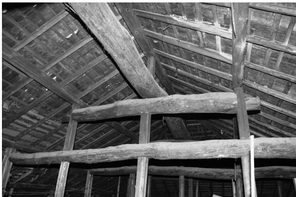
写真⑧ 小屋組 見上げる
