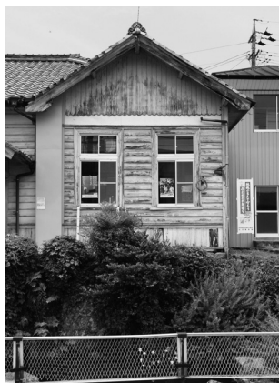
写真③ 正面左翼部分
