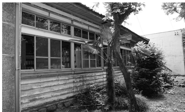
写真⑦ 外観北面
