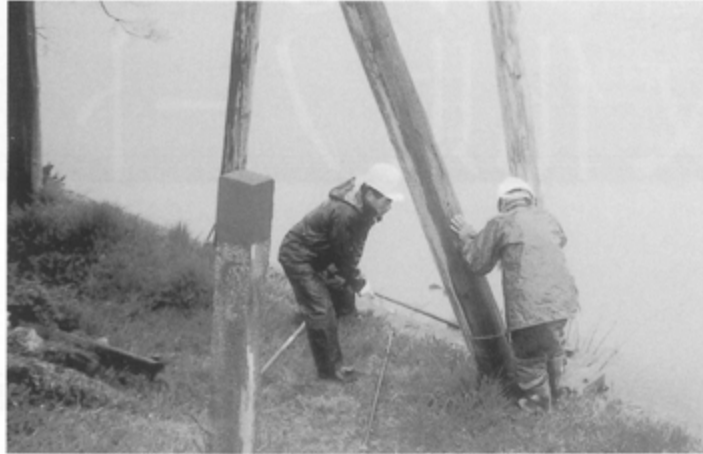
川合のムクノキ 支柱修理作業
