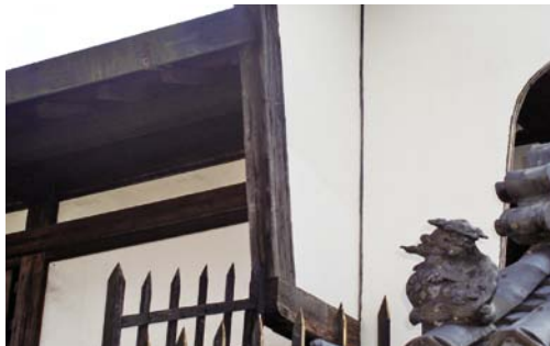
修繕されたうだつの袖壁
