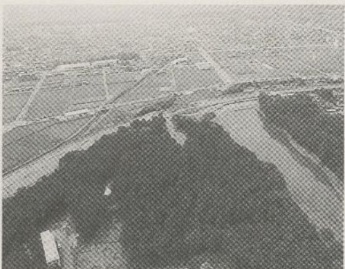
▶建設地上空から市街地を望む
