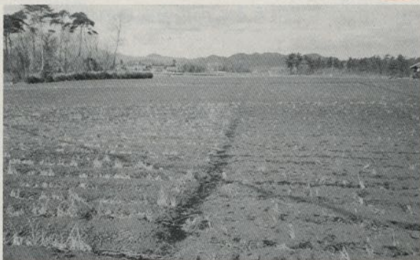
加茂野変電所北側（昭和 36～37 年ごろ）
