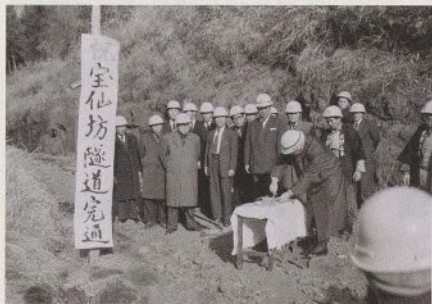
▲「宝仙坊トンネル」工事(昭和37年)
