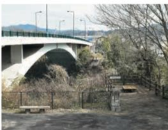
▲森山町側から見た旧青柳橋と青柳大橋
