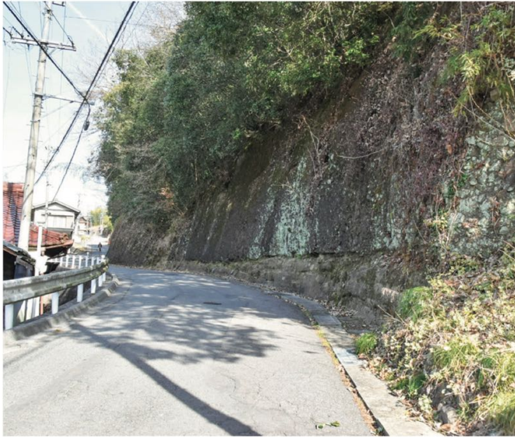
▲火山角れき岩(上部)と火砂岩・泥岩(下部)の地層が連なる蜂屋累層
