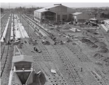
▲建設中のディーゼル基地(昭和40年)
