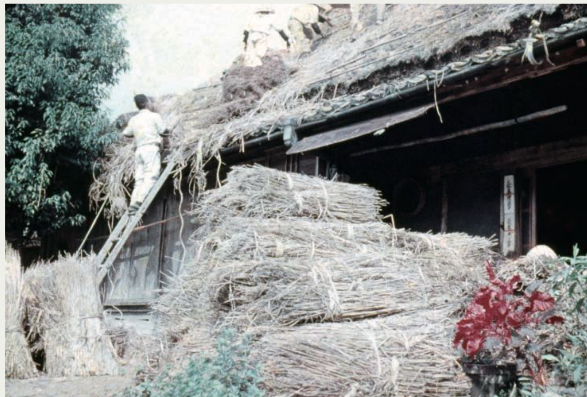
「屋根の葺き換へ(三)」 1963年9月27日 伊深町寺洞
