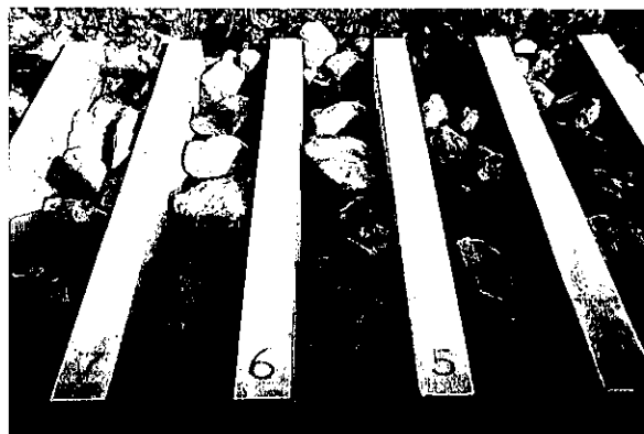
図3. 根固めブロックの基礎部分
