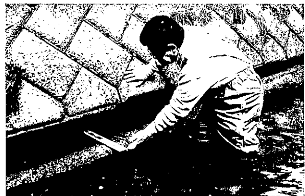
図8. 平成13年(2001)3月護岸の災害状況
