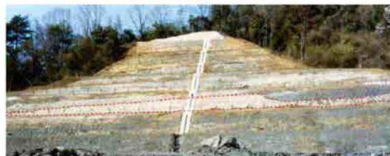
図5 層厚が変化する凝灰岩
