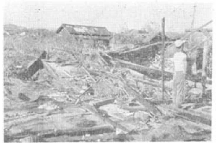
(写真は古井町倒壊状況)
