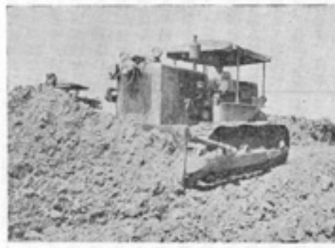
六台のブルドーザーで整地が続けられる
