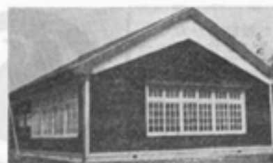
完成した福祉会館
