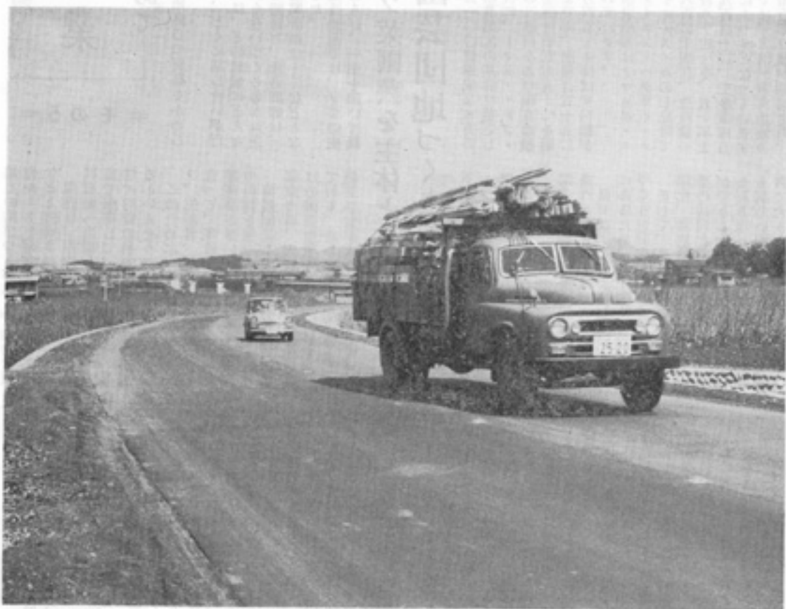
国道21号線と国道248線を結ぶ市道若宮～深田線（太田町地内）が3月に完成しました。
