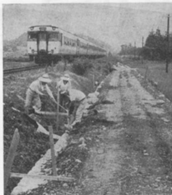
本郷町（上古井）地内で始まった道路新設工事
