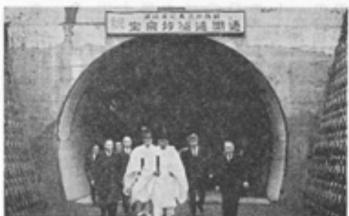
開通した宝泉坊トンネル
