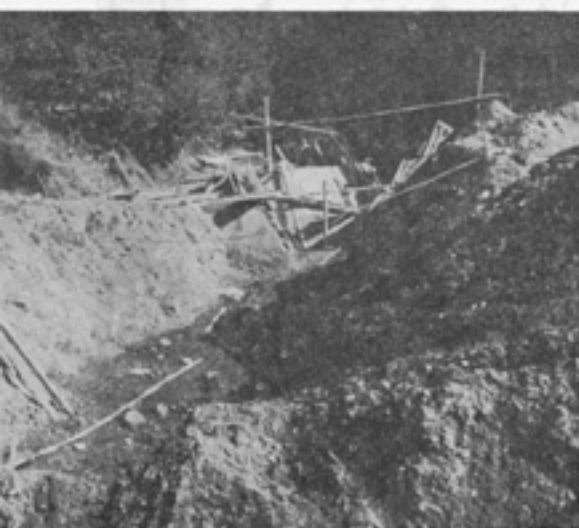
三和町納治地内のいたけ洞川流路工事
