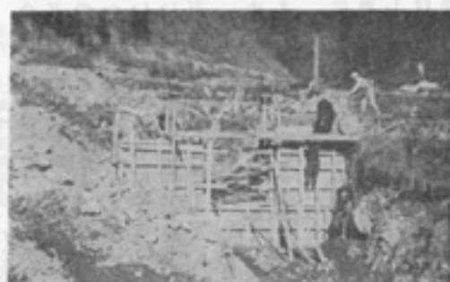
三和町下廿屋の向洞川流路工事
