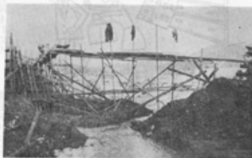
伊深町の別所橋構りょう架設工事
