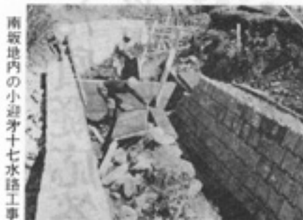
南坂地内の小遊水十七水路工事
