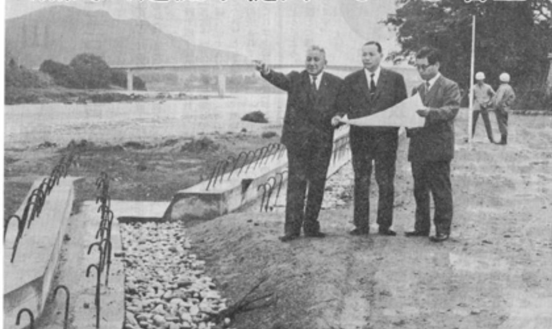
本曾川中流護岸工事の現場を視察し岸市長より陳情をうける渡辺栄一建設政務次官(写真中央)
