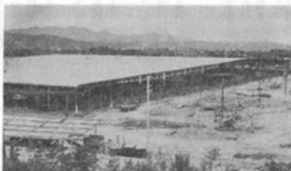
急ピッチで進められている日立製作所岐阜分工場
