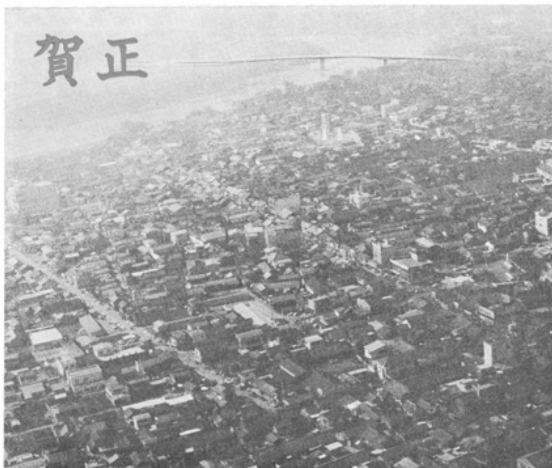
(上空より市街地・中濃大橋を望む)
