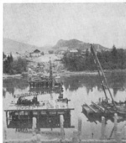
写真 新青柳橋 工事中。来春の完成をめざして『小山観音』の上流で工事が進められています。
