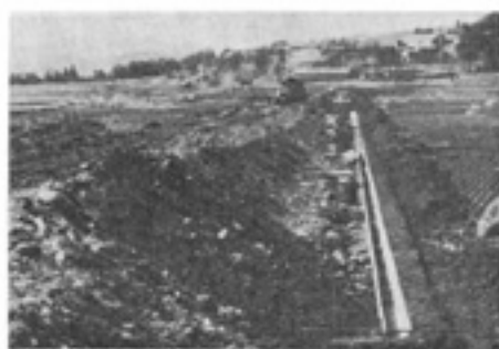
山手線工事中
