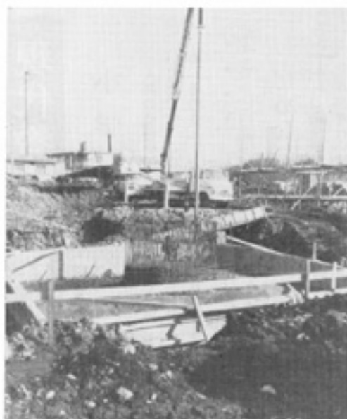
9月完成をめざし、じん芥処理場50トン伊の増設工事（可茂衛生センターに併設）
