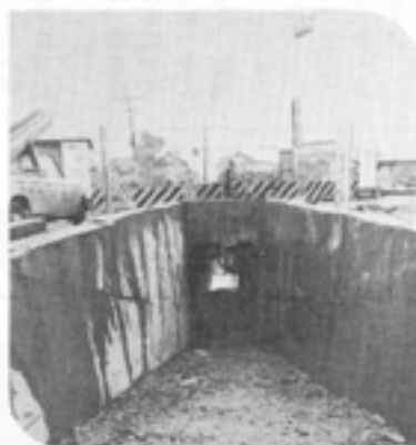
完成近い下古井地下道（下古井郵便局前）
