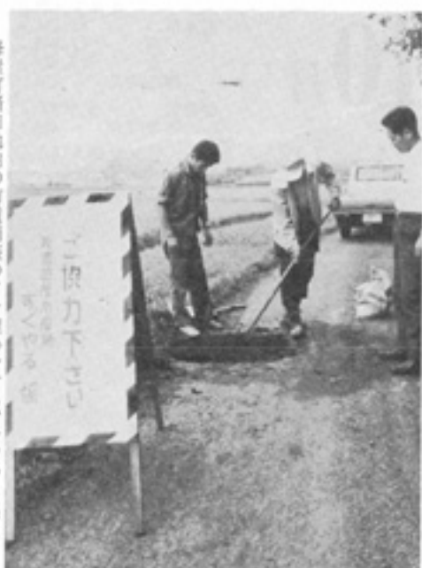
蜂屋町諸田地内の市道舗装のアナ埋めをする、すぐやる係員
