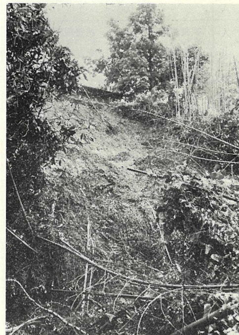
▲ 蜂屋町大洞地内の幅10センチ高さ15センチにわたるガケ崩れ
