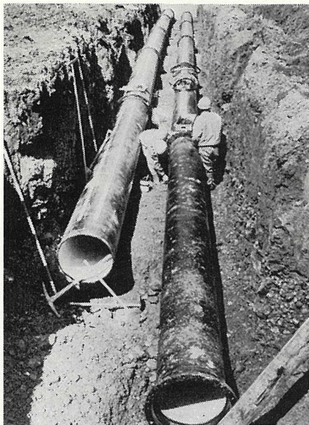
佐口配水池(山之上町)の水道管理設工事
