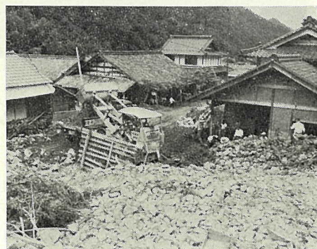
8・17集中豪雨による土砂流出現場
