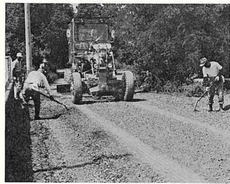
舗装整備が進む市道（清水町）
