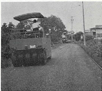
舗装される市道
