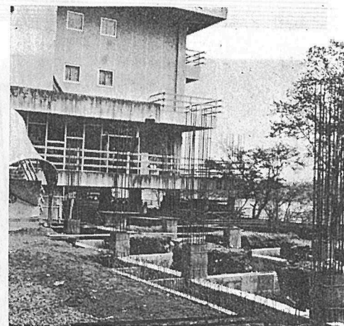
建築が始まった市立図書館
