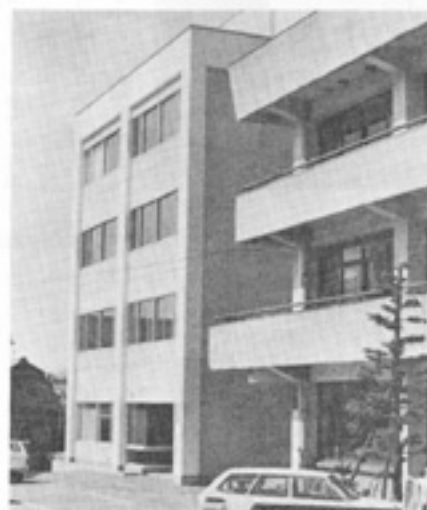
庁舎西に建てられた西館
