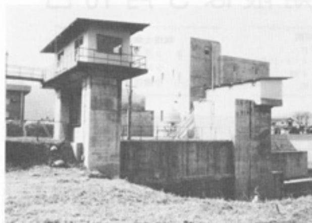
総事業費11億円、ポンプの型式…立軸斜流型、口径…1,500mm、 実揚程…4.0m、排水量…毎秒5mのもの1台(全体計画は5台) 原動機はディーゼルエンジン、出力510馬力が1台(全体計画はポ ンプに合わせて5台)
