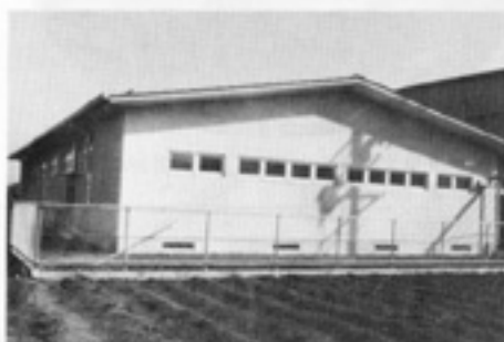
西中格技場完成 総事業費 二億二,三五〇千円 延 三,九二㎡
