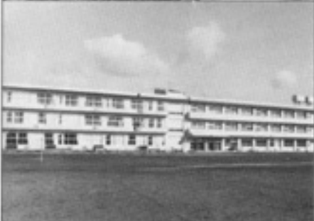
古井小増改築工事完了 (54・55年継続事業) 総事業費 三億一,三七四 延 一,七〇〇千円
