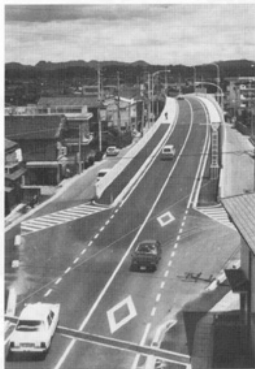
完成した塚渡陸橋
