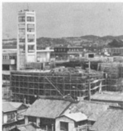
建設がすすむ中央公民館
