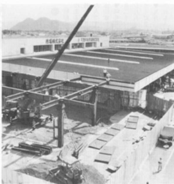
魚ビッチで工事が進む可茂公設卸売市場
