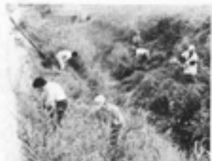
廿屋川の除草作業
