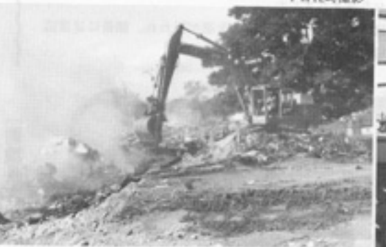
山積みされた災害廃棄物は、10月14日から焼却処理、運搬作業が開始され、ライン河畔も元の姿となりつつある。 14日午前10時撮影
