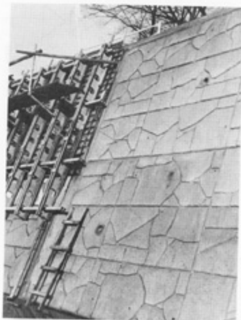
城壁風のコンクリート打ちが行われている下町地内
