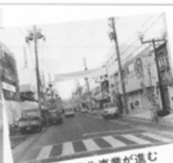
一部を残し、完成した市道山手線北側歩道設置
