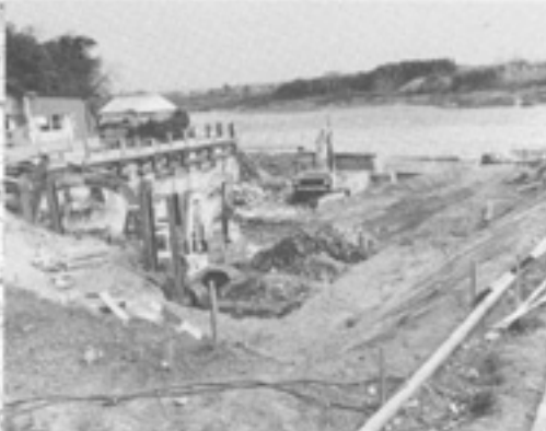
旧太田公民館跡地で建設が進む 神ノ木ポンプ場
