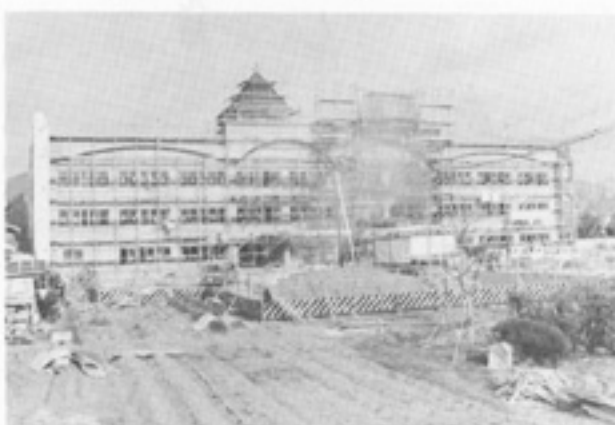
オープンを控え急ピッチで工事進む
