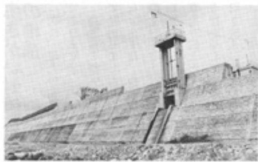
バラベットの陶板を設置
