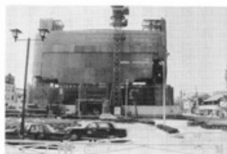
建設進むシティホテル美濃加茂
