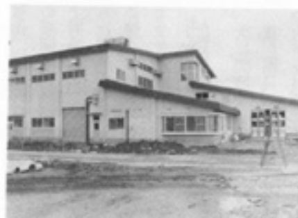
美しいし尿浄化槽
