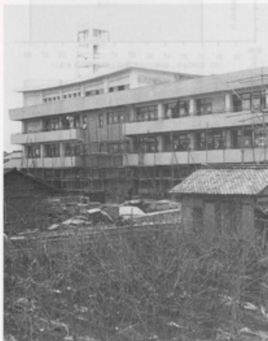
新市庁舎の建設
