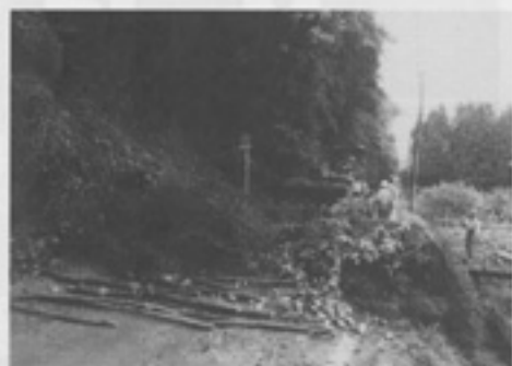
＜崩れ落ちた土砂にうまる県道…三和＞
