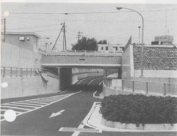
完成した飛鹿跨道橋
