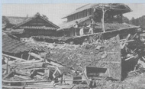
▲昭和34年の伊勢湾台風で壊れた住宅
